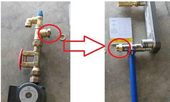
10. Présenter ensuite l'assemblage Pompe / Vanne de réglage / soupape, de façon à le présenter en face de l'entrée du circuit secondaire de l'échangeur (connexion inférieure gauche). Ne pas oublier le joint plat.
