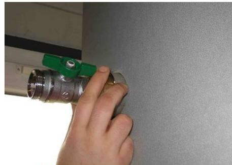
3. Installer la pièce de sortie eau chaude sur le piquage vertical supérieur du ballon.
