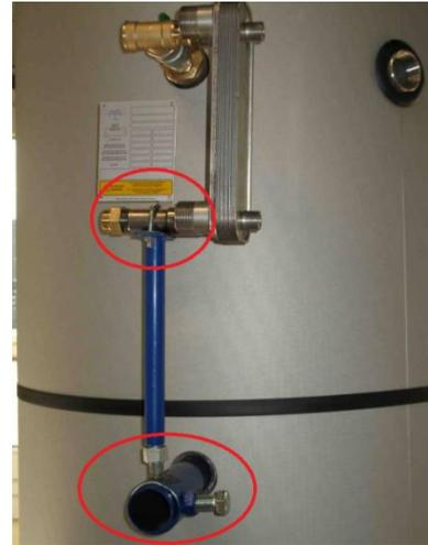
9. Ajuster l'ensemble afin que l'échangeur soit bien vertical et parallèle à la paroi du ballon. Ceci fait, serrez les vis de blocage de l'anneau support.
