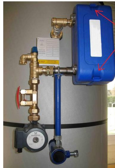
11. Installez le calorifuge de l'échangeur en assemblant les deux ½ coquilles et en les fixant à l'aide des clips en plastique, en haut et en bas de l'échangeur.
