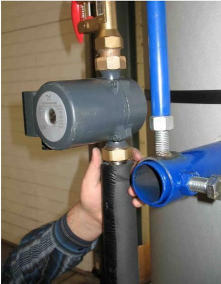
12. Raccordez la partie haute du flexible calorifugé à la pompe.
