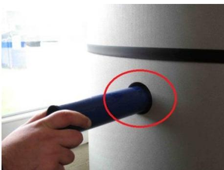
6. Visser la bobine support sur le manchon borgne du ballon. Sur les modèles 300 L, utiliser le manchon inférieur gauche
