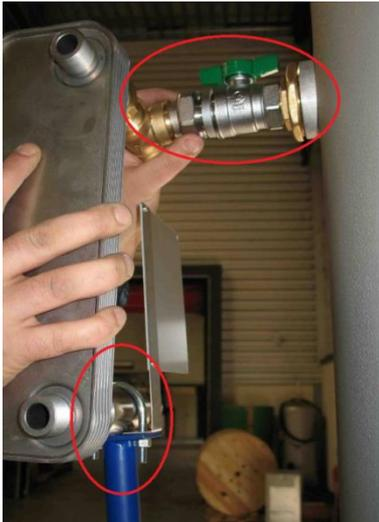
8. Effectuer un 1er positionnement en emboîtant la tige filetée du support dans le tube et en vissant le raccord union en sortie échangeur à la vanne d'isolement déjà installée sur le ballon.
